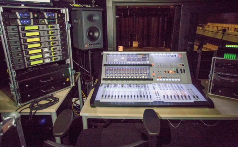
Jako konsola frontowa w drugiej co do wielkości sali ICE pracuje Soundcraft Vi2, a Vi1 pełni rolę miksera monitorowego.
