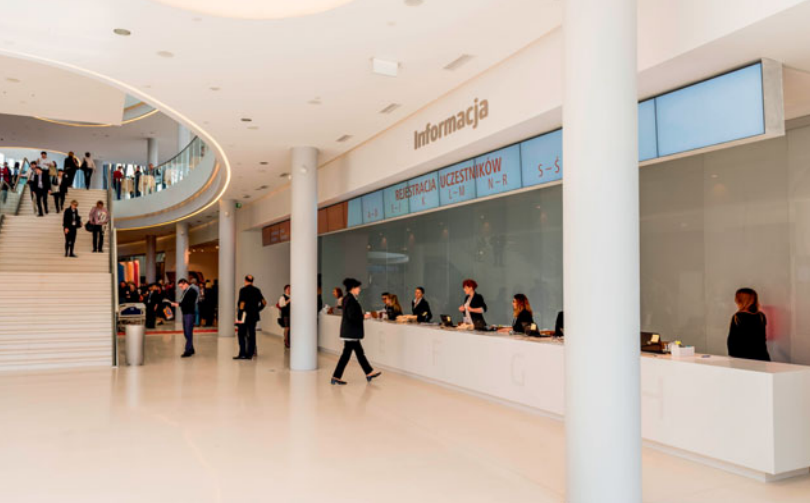
Na foyer firma ProAudio-AVT zainstalowała system digital signage, czyli system informacji wizualnej, w tym dwie linie monitorów nad kasami.
