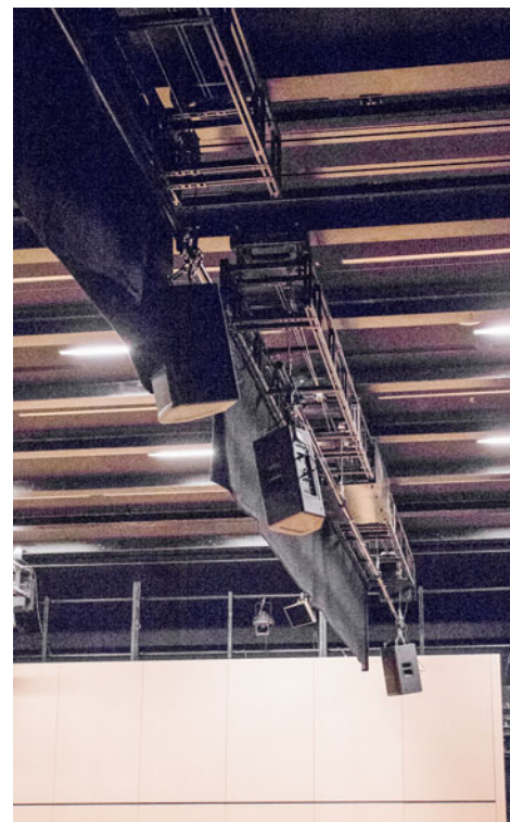
W wielofunkcyjnej Sali Kameralnej, z uwagi na jej charakter, system nagłośnienia skonfigurowany został z elementów mobilnych.
